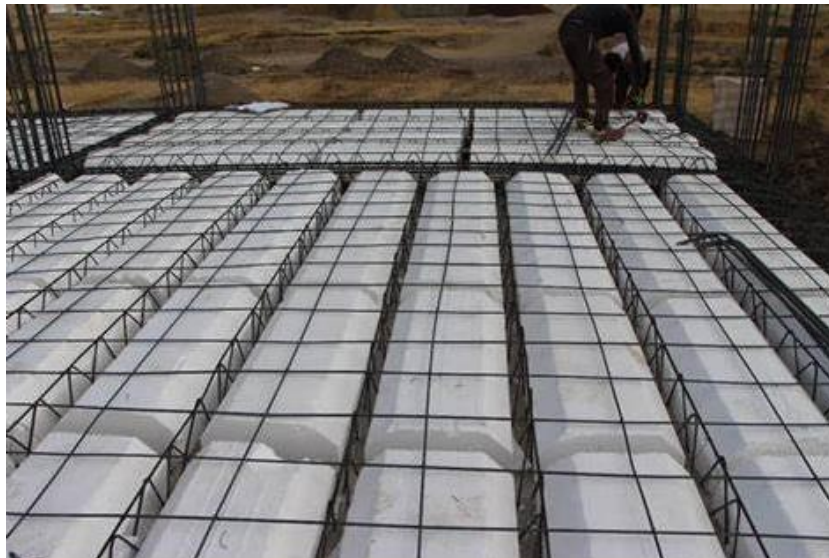
شکل ۹: نمایی از سقف تیرچه بلوک با بلوک پلی استایرن
