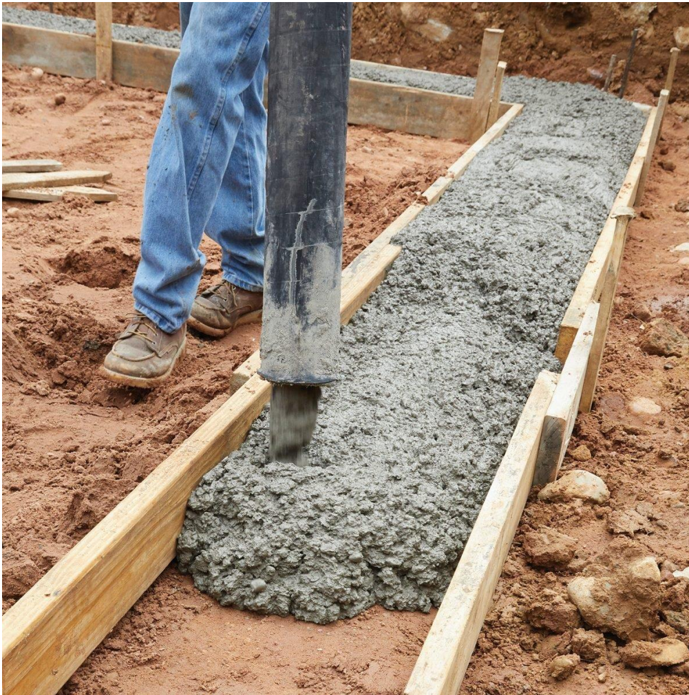
شکل ۶: پخش بتن مگر آماده
