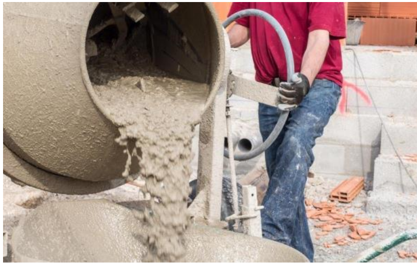
شکل ۷: ساخت بتن مگر دستی در کارگاه
