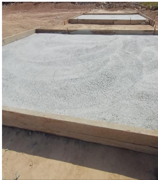
شکل ۸: قالب‌بندی بتن مگر با قالب چوبی
