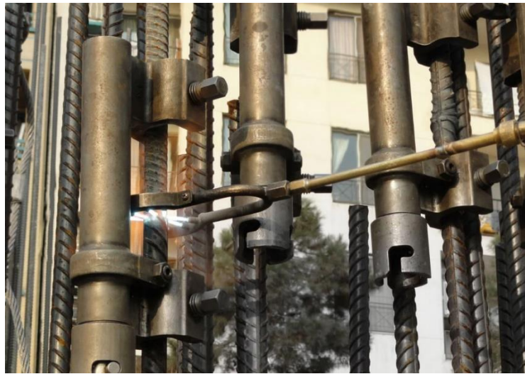
شکل ۶- تنظیم دقیق آرماتورها توسط گیره و حرارت دهی با مشعل
