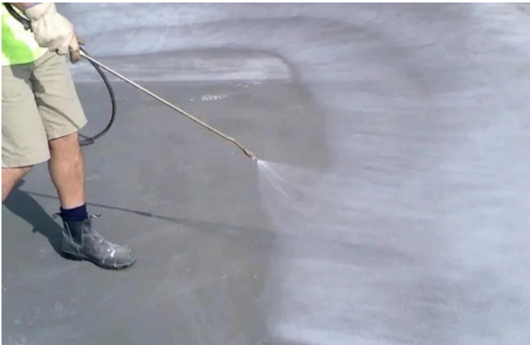
شکل ۶: استفاده از مواد غشاساز بتن برای کیورینگ بهتر
