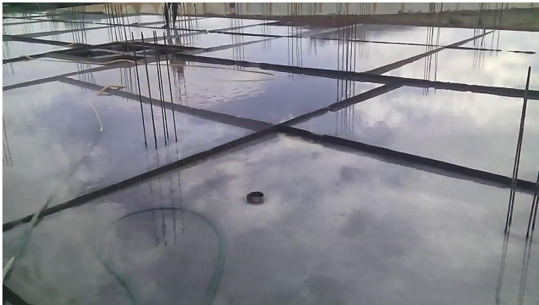
شکل ۴: ایجاد حوضچه آب برای عمل آوری بتن
