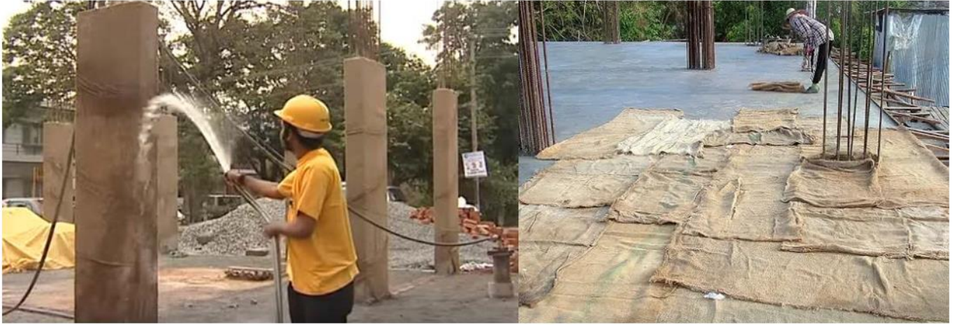
شکل ۵: استفاده از چتایی خیس برای عمل‌آوری بتن
