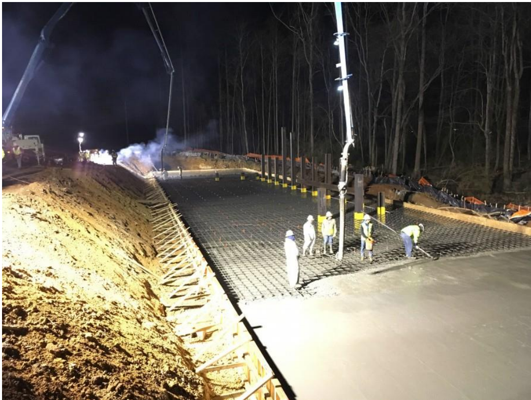
شکل ۸: عملیات بتن ریزی در شب
