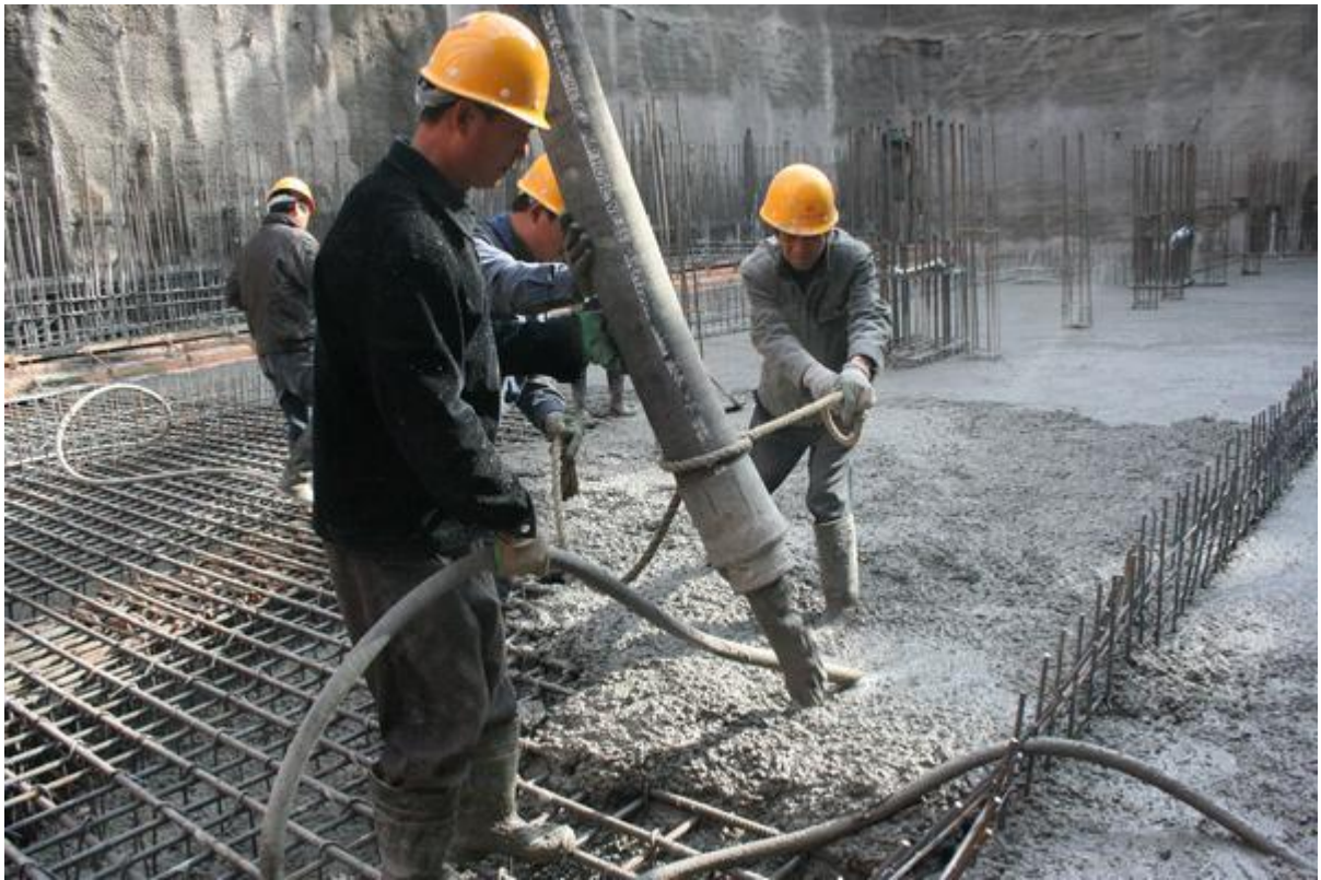
شکل ۱: بتن ریزی در هوای گرم
