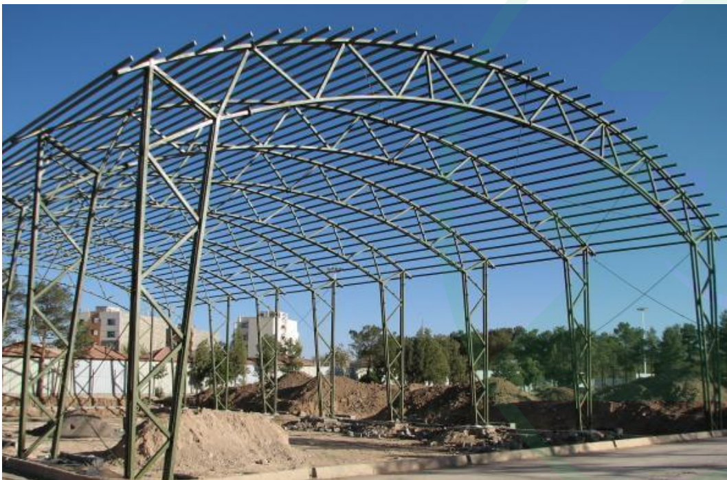
سوله کاملاً خرپایی ساخته شده از قوطی
