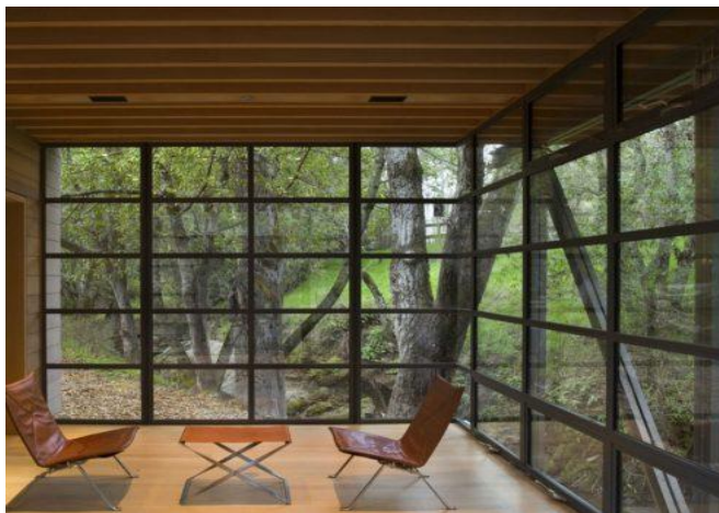
عدم زیبایی نما بخاطر وجود مهاربند
