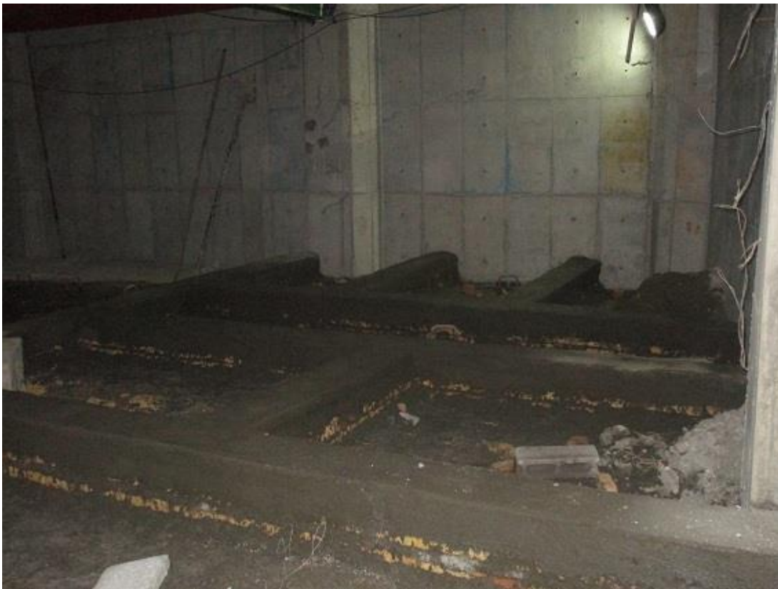
شکل ۲۳: لیسهای شدن بستر ایزولاسیون بر روی کرسی چینی
