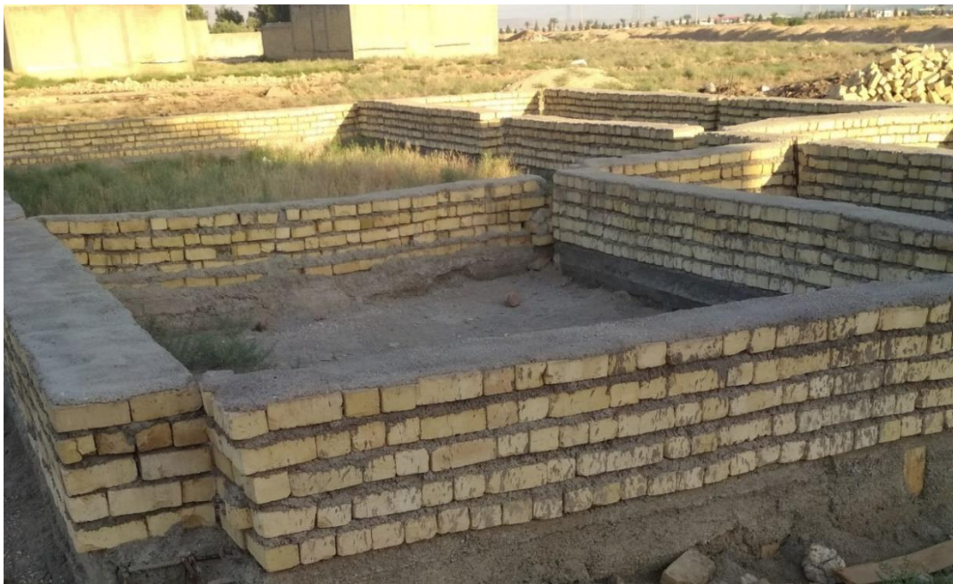
شکل ۴: کرسی پیش از شروع عملیات ایزولاسیون
