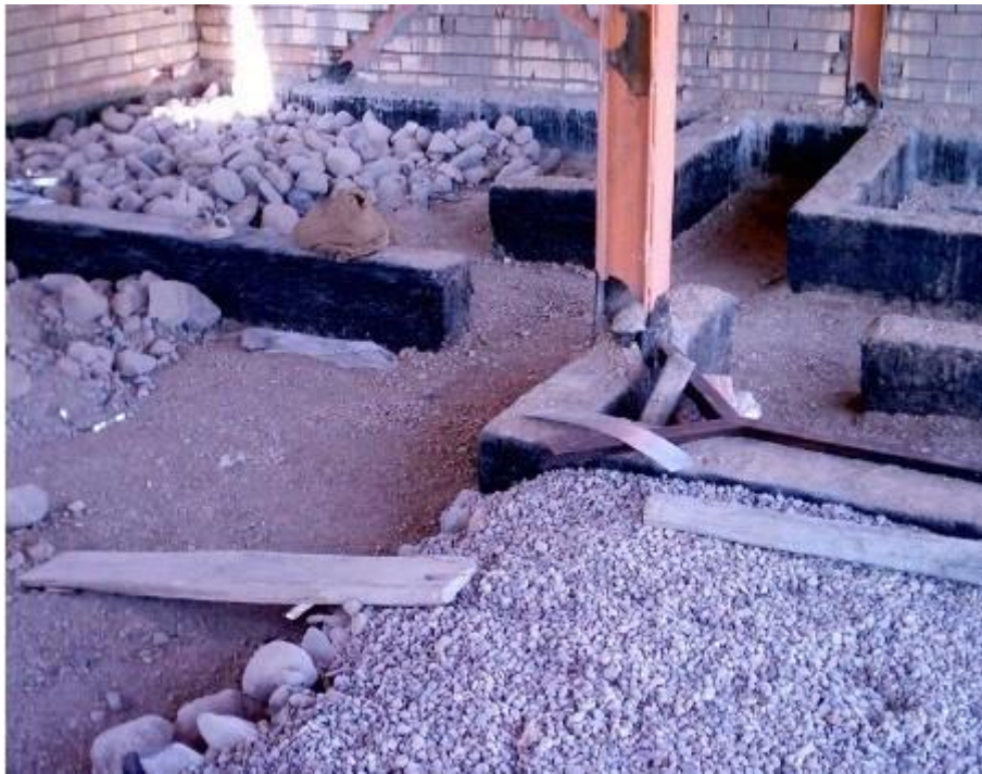
شکل ۱۷: بلوکاژ تا تراز کرسی
