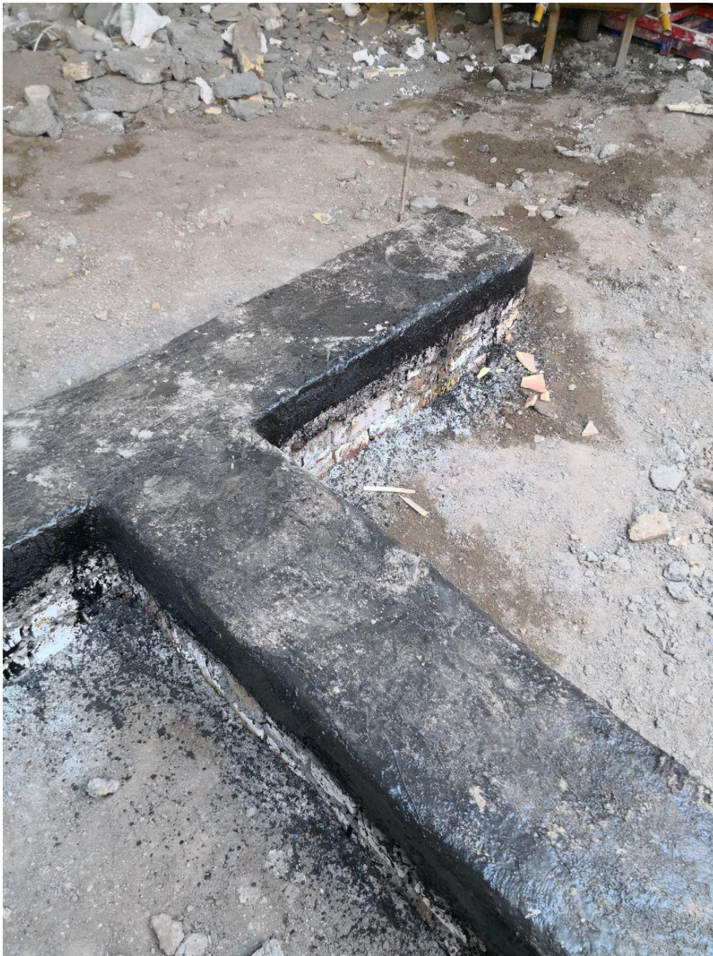
شکل ۲۵: ایزولاسیون روی کرسی
