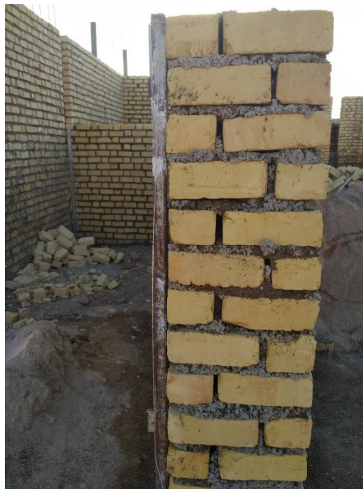
شکل ۲۲: استفاده از شمشه برای شاقول کردن دیوار
