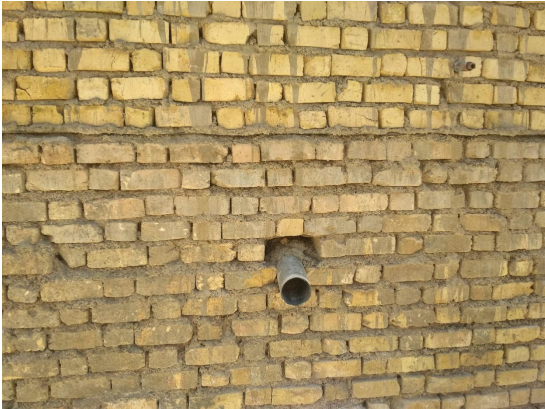
شکل ۱۹: عبور تأسیسات از زیر تراز عایق رطوبتی
