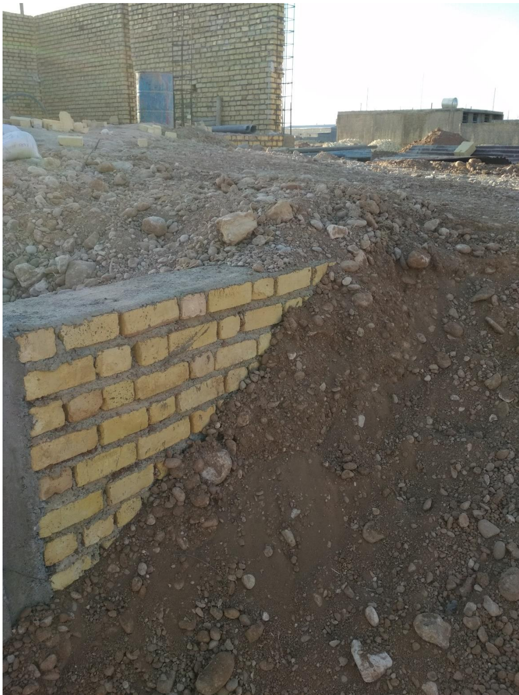
شکل ۱۸: پرکاری با مخلوط گل و قلوه سنگ
