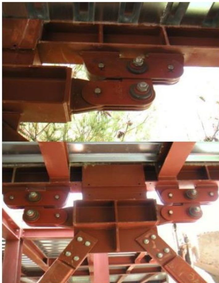
شکل ۱۷ نوعی دیگر از میراگر اصطکاکی در سازه‌ها
