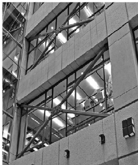
شکل ۱۶ میراگر اصطکاکی در سازه‌ها
