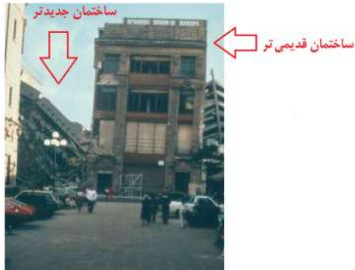
شکل ۴- تخریب کامل ساختمان جدید در اثر برخورد با ساختمان قدیمی
