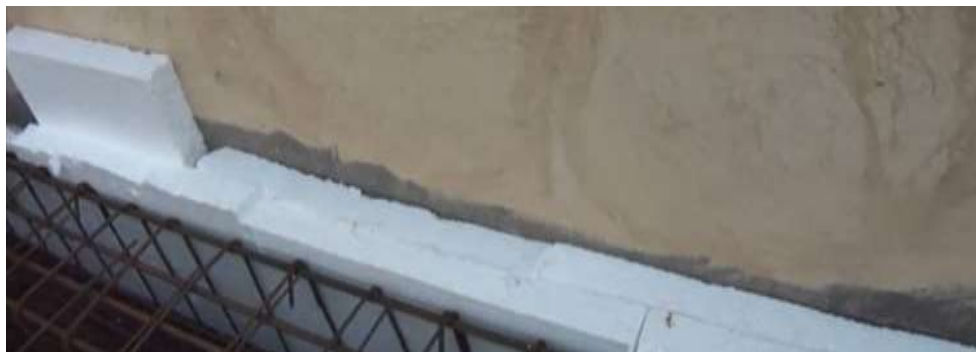
شکل ۲۵- پر کردن درز انقطاع در فونداسیون با یونولیت
