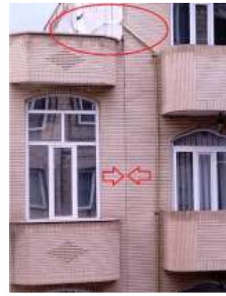
استفاده از فضای درز انقطاع برای عبور لوله های گاز در ساختمان سمت راست - عدم رعایت فاصله درز انقطاع
