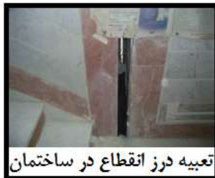
شکل ۲۲- کاربرد در انقطاع در منظم کردن پلان‌های پیچیده
