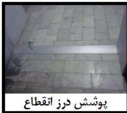
شکل ۲۲- کاربرد در انقطاع در منظم کردن پلان‌های پیچیده
