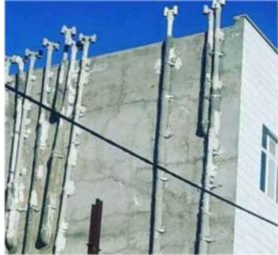
عبور لوله و تأسیسات از محل درز انقطاع
