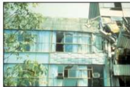
خسارت در اثر تنه زدن - زلزله مکزیکوسیتی (۱۹۸۵)
