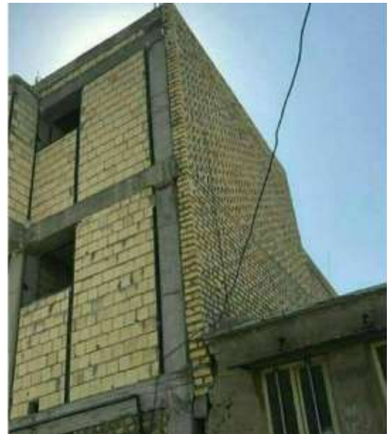
اجرای یکسره دیوار و عدم استفاده از وال پست - پر کردن درز انقطاع برای استفاده بیشتر از فضا !!
