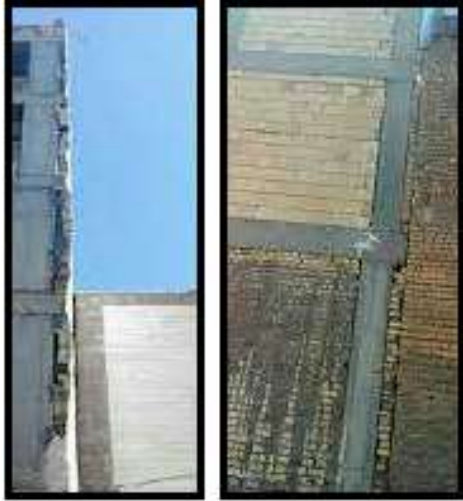
پر کردن درز انقطاع برای استفاده بیشتر از فضا !!
