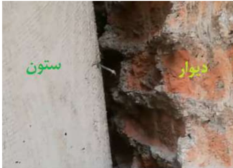
شکل ۲۶- کنترل درز انقطاع در مواجهه به سطح ناصاف دیوار ملک مجاور
