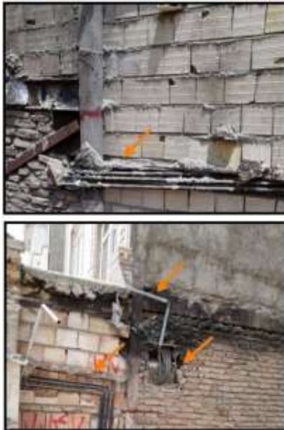
استفاده از فضای درز انقطاع برای عبور لوله‌های گاز و برق
