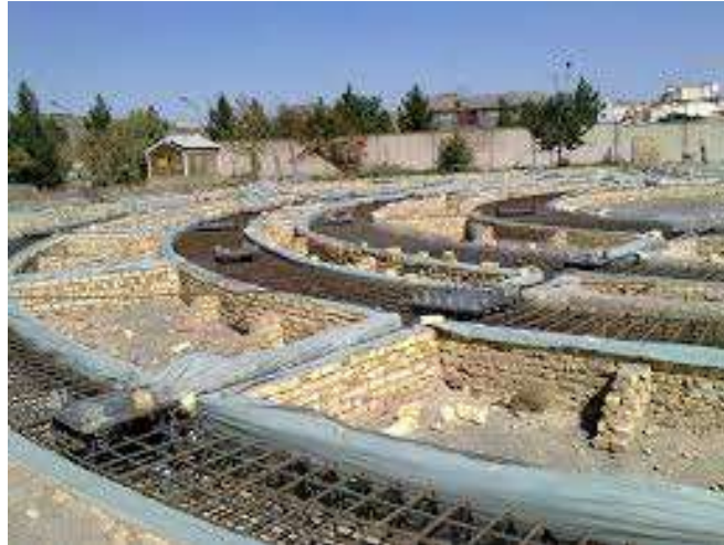
شکل ۵: قالب بندی پی با مصالح بنایی
