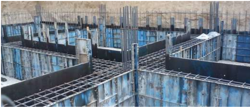
شکل ۳: قالب بندی پی با مصالح فلزی
