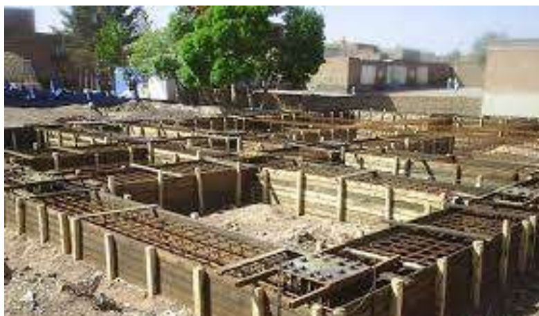
شکل ۴: قالب بندی پی با مصالح چوبی
