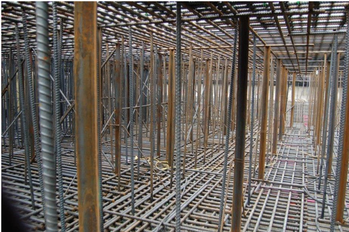
شکل ۲۳ خرک‌ها به صورت آرماتورهای قائم در فونداسیون
