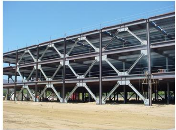
شکل ۲۳- محدودیت‌های مهاربند شورون هفتی و هشتی
