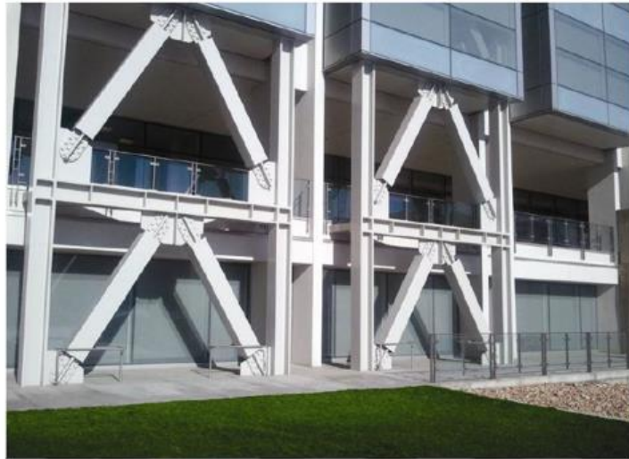
شکل ۵- مهاربند شورون هشتی
