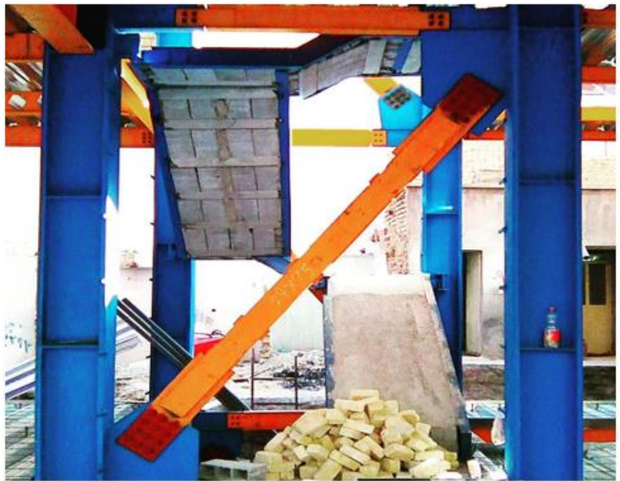
شکل ۴- مهاربند قطری
