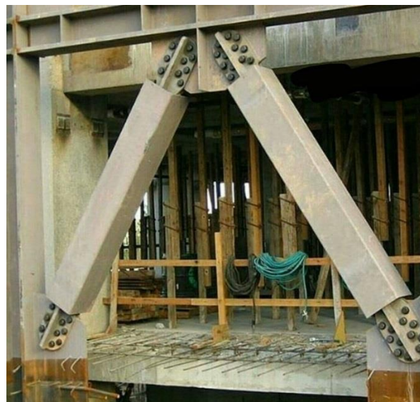
شکل ۱۷ - نمونه اجرا شده مه‌اربند کمانش ناپذیر
