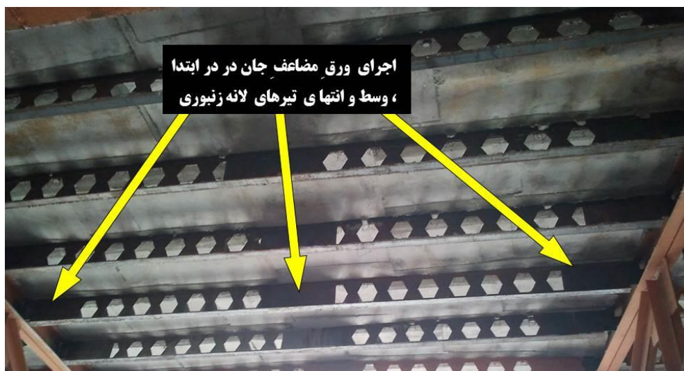
شکل ۸- روش اجرایی تقویت تیرهای لانه زنبوری
