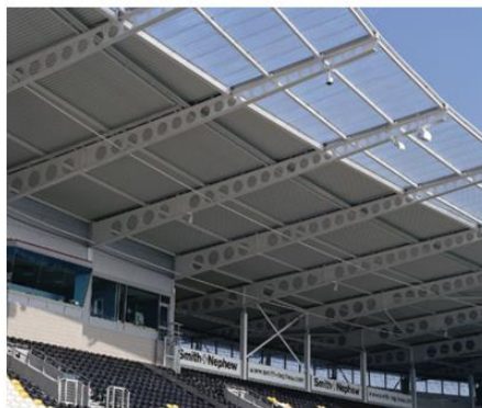
شکل ۱۲ - استفاده از تیرهای قوسی لانه زنبوری و سلولی
