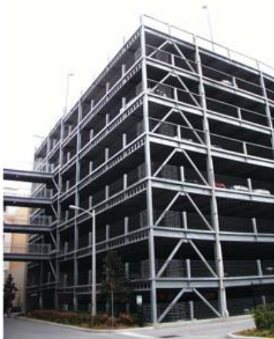
شکل ۹ - استفاده از تیرهای لانه‌زنبوری و سلولی در سازه‌های پارکینگ
