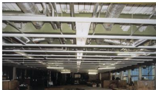
شکل ۱۱- عبور تأسیسات تهویه ی هوای مطبوع از میان مقاطع با جان باز (تیرهای لانه زنبوری و سلولی)
