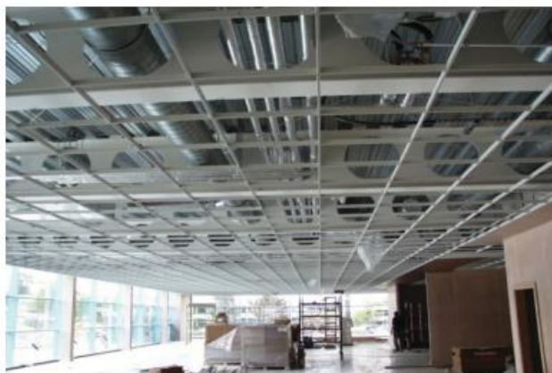
شکل ۱۱- عبور تأسیسات تهویه ی هوای مطبوع از میان مقاطع با جان باز (تیرهای لانه زنبوری و سلولی)
